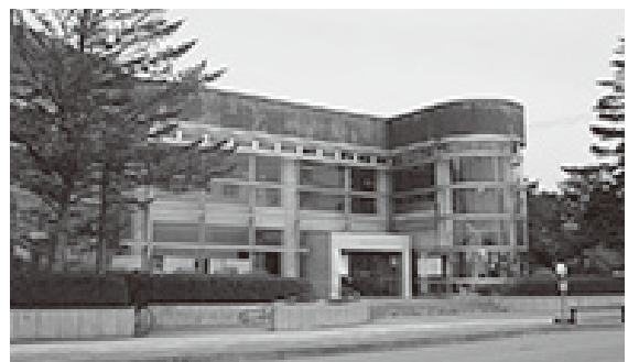
整備後30年が経過する市民プール
