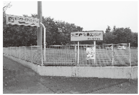
災害時応急給水所（伊勢原町）
