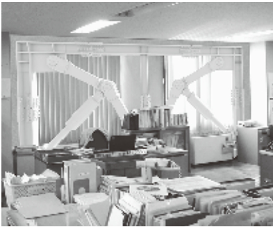
耐震補強後の事務室イメージ
