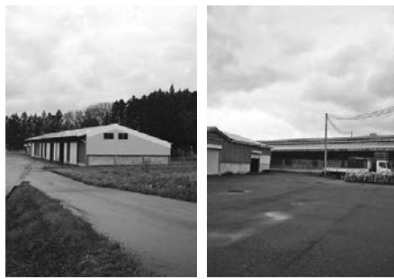
藤島エコ有機センター(左)と 羽黒高品質堆肥製造施設
