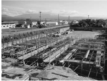
改築工事中の藤島分署
